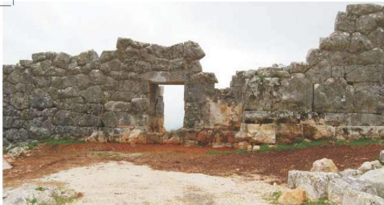
Η βορειοανατολική πύλη μετά τις εργασίες καθαρισμού και μερικής αναστήλωσής της
