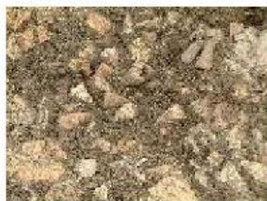
Σύνολο αγνύθων από το κτίριο 11
