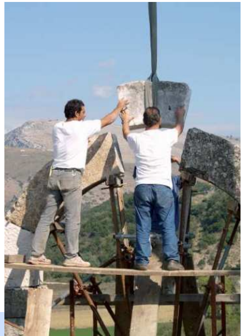
Αποκατάσταση της κύριας πύλης Π1.
