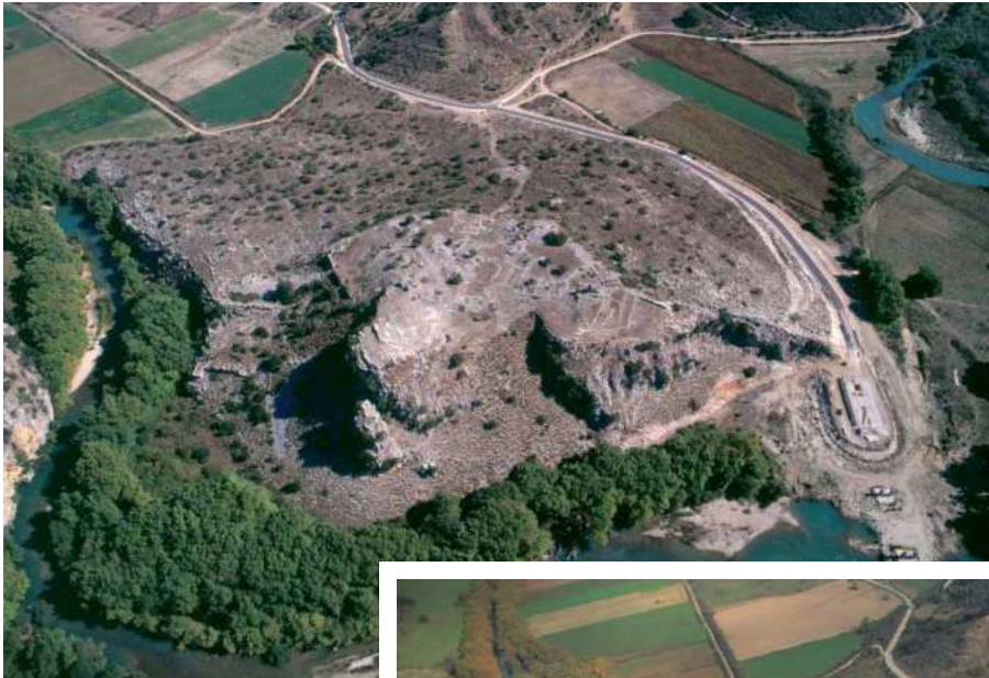
Ο αρχαιολογικός χώρος της Ντόλιανης πριν και μετά τις εργασίες ανάδειξης.
