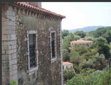
εικ. 29. Δημοτικό σχολείο Φοινικίου
