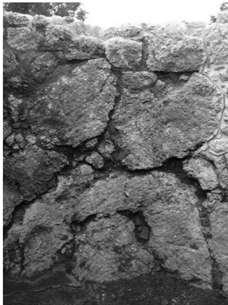
17α-β. Η εσωτερική επιφάνεια της δεξαμενής του Κτιρίου Β, πριν και μετά τις εργασίες συντήρησης
