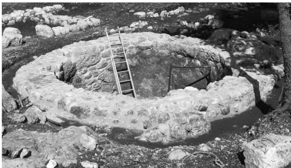
15α-β. Η δεξαμενή του Κτιρίου Β, πριν και μετά την αποκατάσταση των τοιχωμάτων της.
