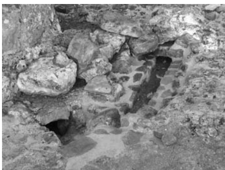
19α-β. Στάδια αποκατάστασης του νεώτερου αγωγού της δεξαμενής του Κτιρίου 12.
